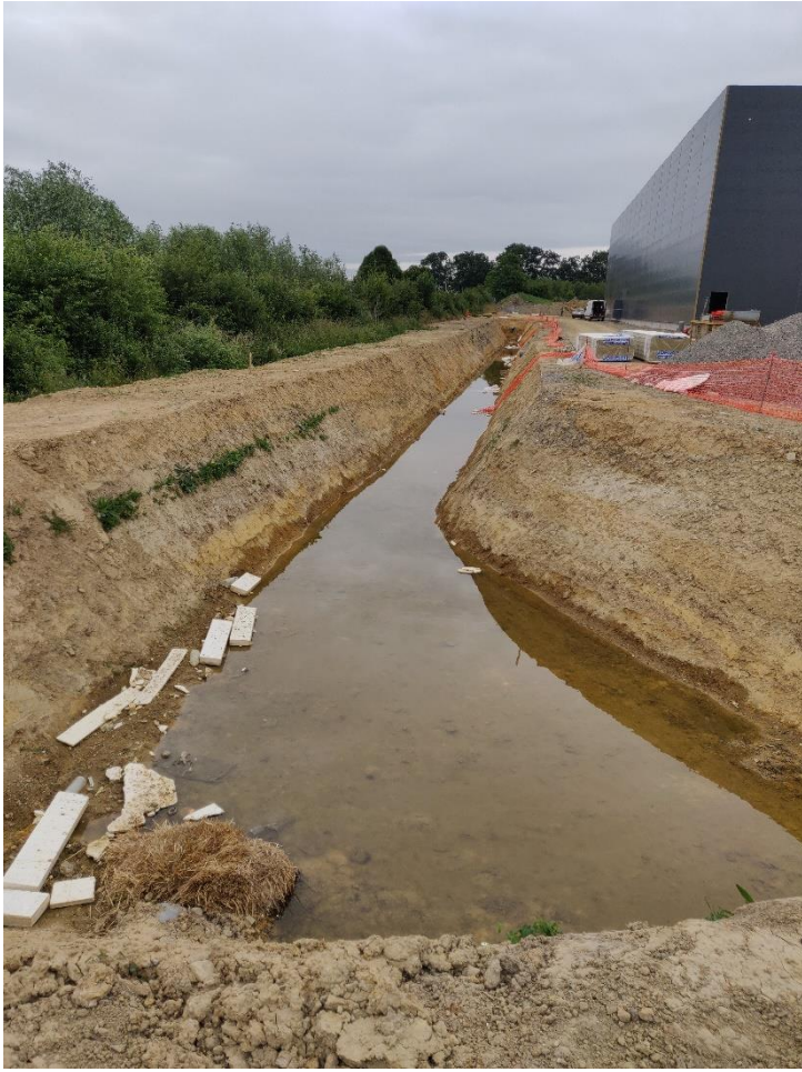
PRECISION SUR GESTION EAUX PLUVIALES PHASE CHANTIER
