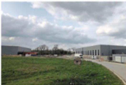
À quelques mètres de la route 27 de l'autoroute, la zone de Sévantes est en train de se développer. C'est au bord de cette récente voie qu'ambierait Bridor. (Photo: Geoffroy)
